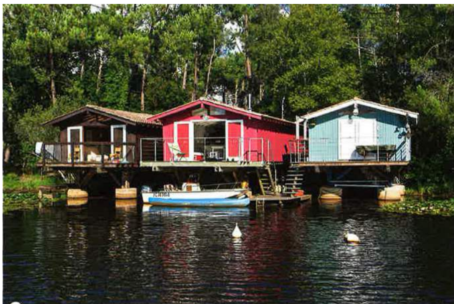
Marina de Talaris à Lacanau, Agence Agora et Jean Claude Moreau. La construction du hameau de Pêcheries s'inspire des cabanes de pêcheurs du bassin d'Arcachon.
